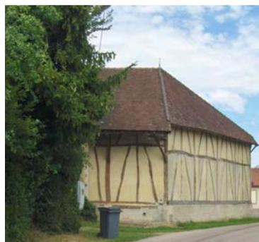
Les matériaux les plus couramment utilisés sont le pan de bois, la brique et le carreau de craie. A la différence de la région de Vitry-le-François, où le remplissage des pans de murs se fait à base de torchis, à Montgueux la brique est plus utilisée. Ce matériau est, dans ce secteur, beaucoup plus fréquent que dans d'autres où il ne sert habituellement que pour l'encadrement des ouvertures.
