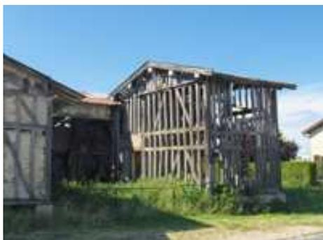
Seule l'armature du pan de bois est encore en place. Le torchis, plus fragile, a entièrement disparu, laminé par les intempéries, Changy
